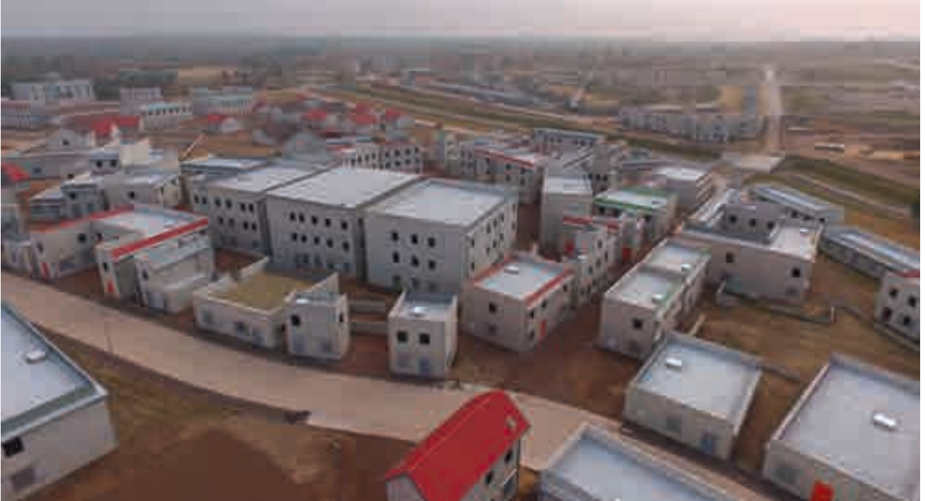
Abbildung 39: Urbaner Ballungsraum „Schnöggersburg“
