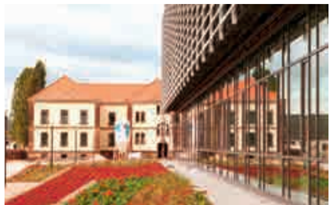
Abbildung 36: Offizierschule Dresden – Die Offizierschule des Heeres in der damaligen „Albertstadt-Kaserne“ in Dresden am Tag der offiziellen Eröffnung nach der Sanierung, 14. September 1998
